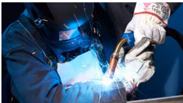
Aufschweißen eines beschädigten Werkzeuges (MAG-Verfahren)
